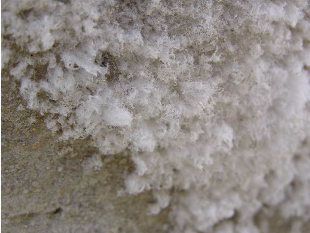
Рис. 5.10. Макро-фото висолів на поверхні.
