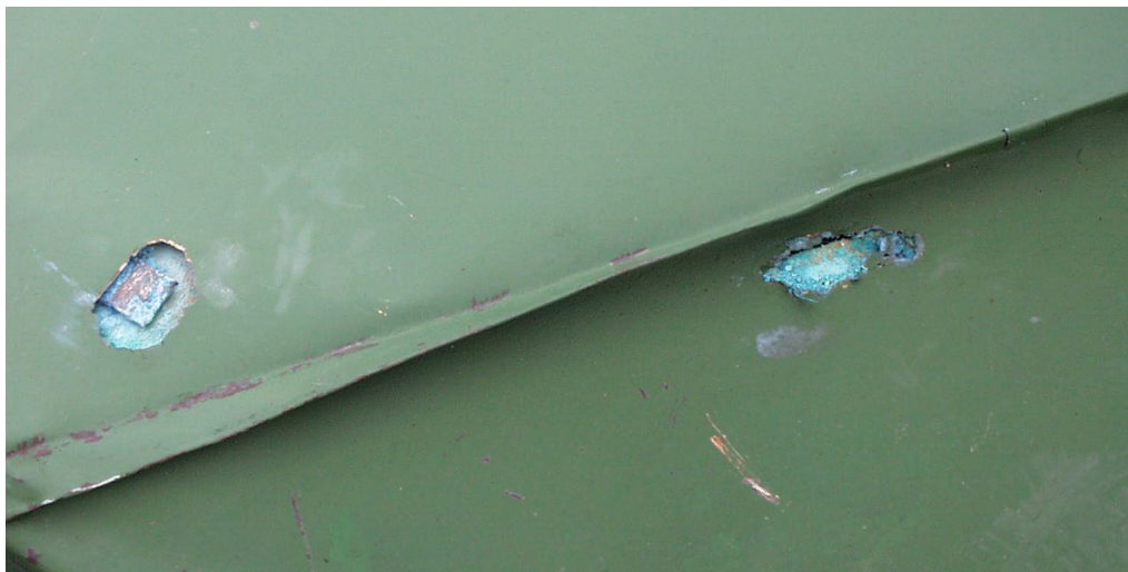
Рис.1.2. Корозія мідної покрівлі за один рік в результаті обробки дерев'яних конструкцій і обрешітки солями амоній фосфатів (антипіренів)
