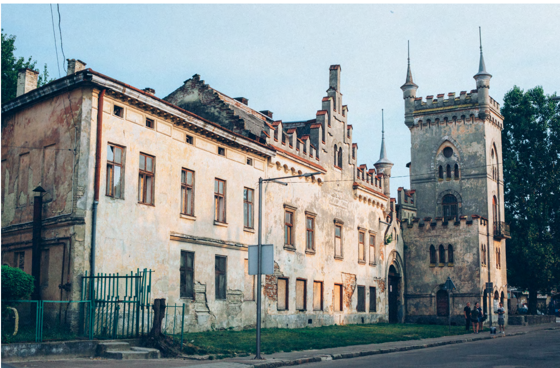
Фабрика повидла до ремонту. Фото: Володимир Палій, 2015 р.
