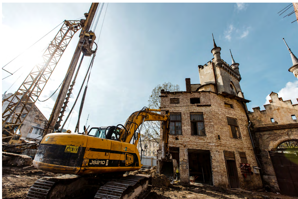
Будівельні роботи на фабриці, 2020 р. Джерело: Колекція арт-центру «Фабрика повидла».
