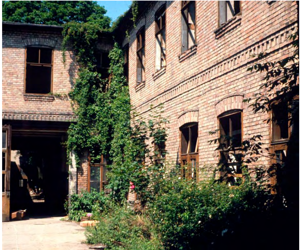
"Sargfabrik" перед початком процесу перевикористання, вид з двору. Фото: ВКК Architects.
